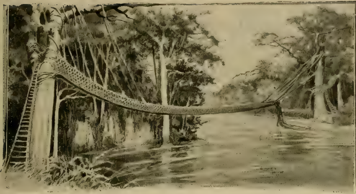
PONT DE LIANES SUR LE CAVALLY.
